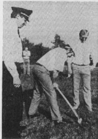
Hünfelds Bürgermeister beim ersten Spatenstich. Wehrführer Karl Fey (links) und Ortsvorsteher Eberhard Lohfink beobachten den symbolischen Baustart.
